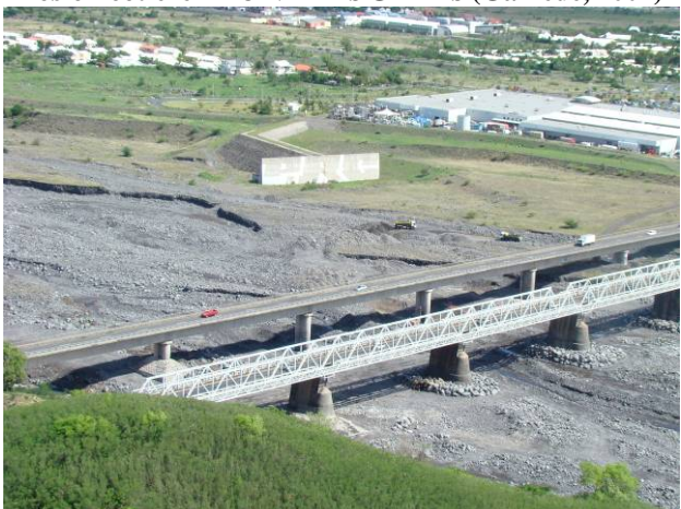
Inondations et érosion de berges – RIV. DES GALETS
