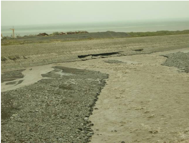
Inondations, érosion de berges – RIV. DES GALETS (Gamède, 2007)
